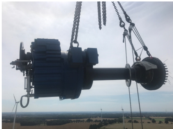
Triebstrangtausch an einer NEG Micon NM 60 - Windenergieanlage
