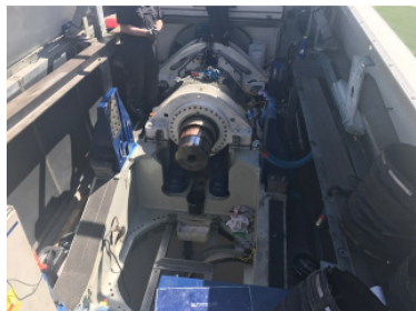
Wechsel eines VESTAS V 80-Getriebes durch StiegeWind
