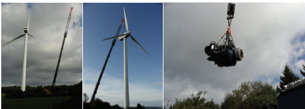
Bild: Ausbau eines Getriebes bei einer VESTAS V 63 RCC Windenergieanlage
