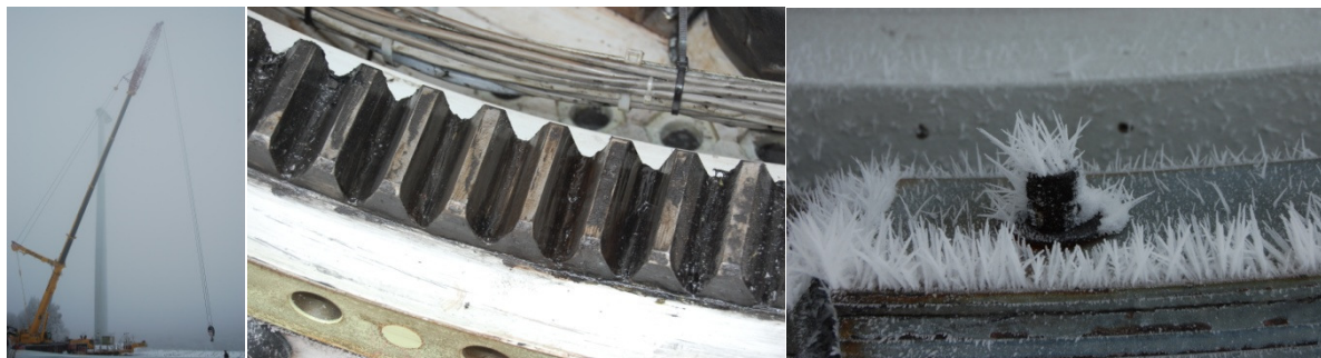
Bilder: Tausch eines Getriebes bei einer FRISIA F-56 Windenergieanlage und Detailaufnahmen
