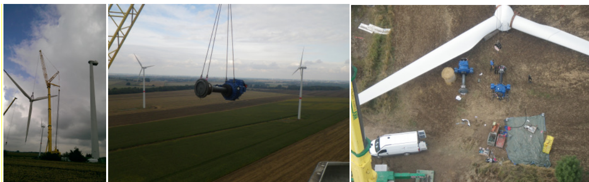
Bilder: Tausch eines Triebstranges an einer NEG Micon 1000/60 in Sachsen-Anhalt durch StiegeWind GmbH
