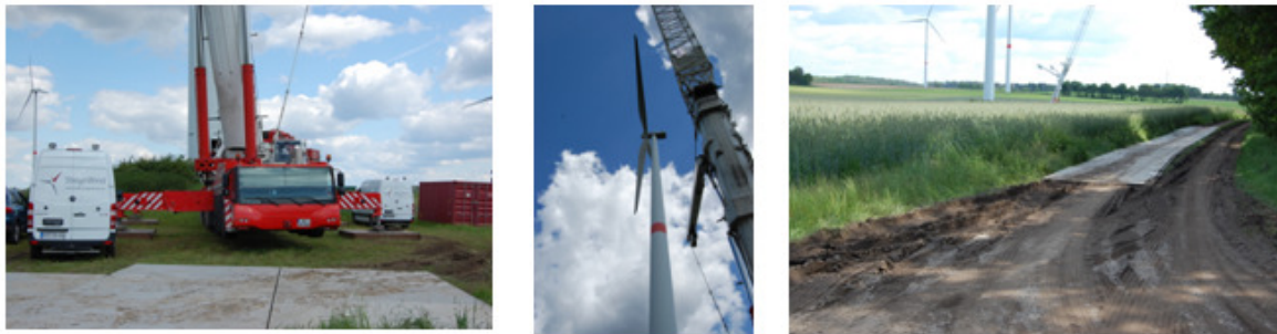
Bild: Generatortausch durch StiegeWind bei einer NEG Micon NM 82 Anlage nach schweren Regenfällen
