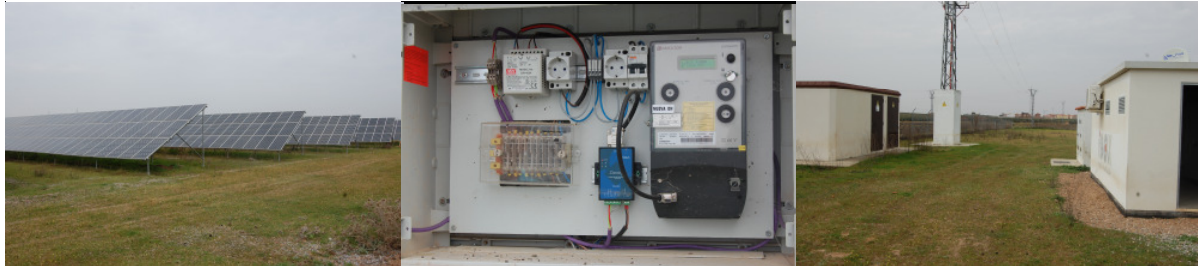
Bilder einer Inspektion des PV- Parks Torremejia
