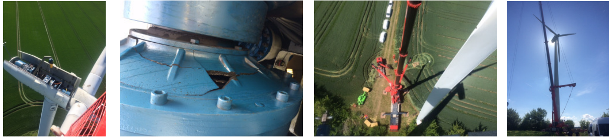
Tausch des kompletten Triebstranges einer Nordex N43 Windenergieanlage durch die StiegeWind GmbH
