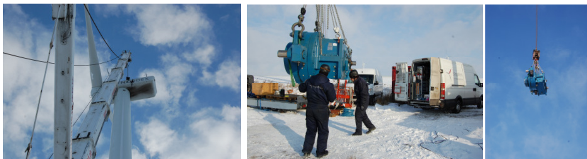
Bilder: Tausch eines N 60 Getriebes in Sachsen-Anhalt durch StiegeWind
