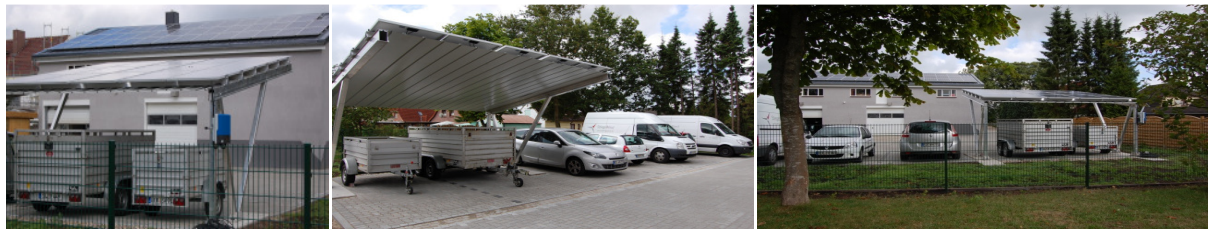
Bilder: Neuer 3,675 kWp-Solarcarport ,im Hintergrund 10 kWp-Dachflächenanlage der StiegeWind GmbH auf dem Zentrallager in Jübek
