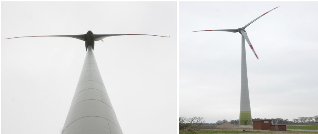
Bild: Enercon E 82 2,3 MW Bürgerwindanlage in Ottersberg
