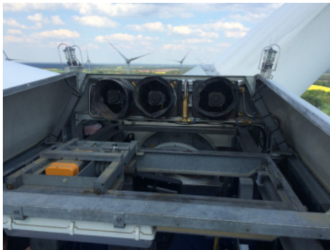
Tausch eines Generators einer VESTAS V 80 Windenergieanlage im Rahmen eines Vollwartungsvertrages der StiegeWind GmbH
